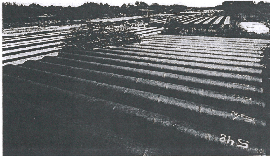
Figura 11 Tubería para pilotes y traves Nebraska almacenadas en patio
