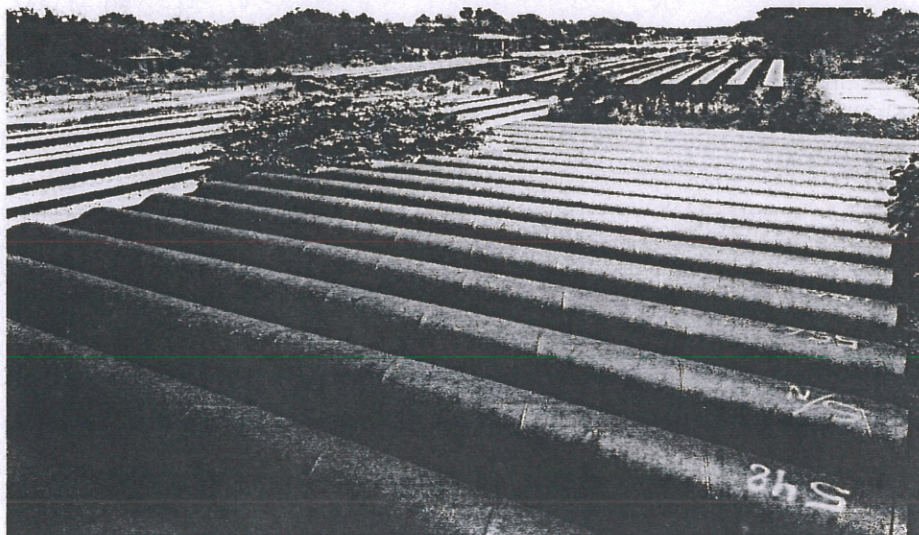
Figura 12 Tubería para pilotes y traves Nebraska almacenadas en patio
